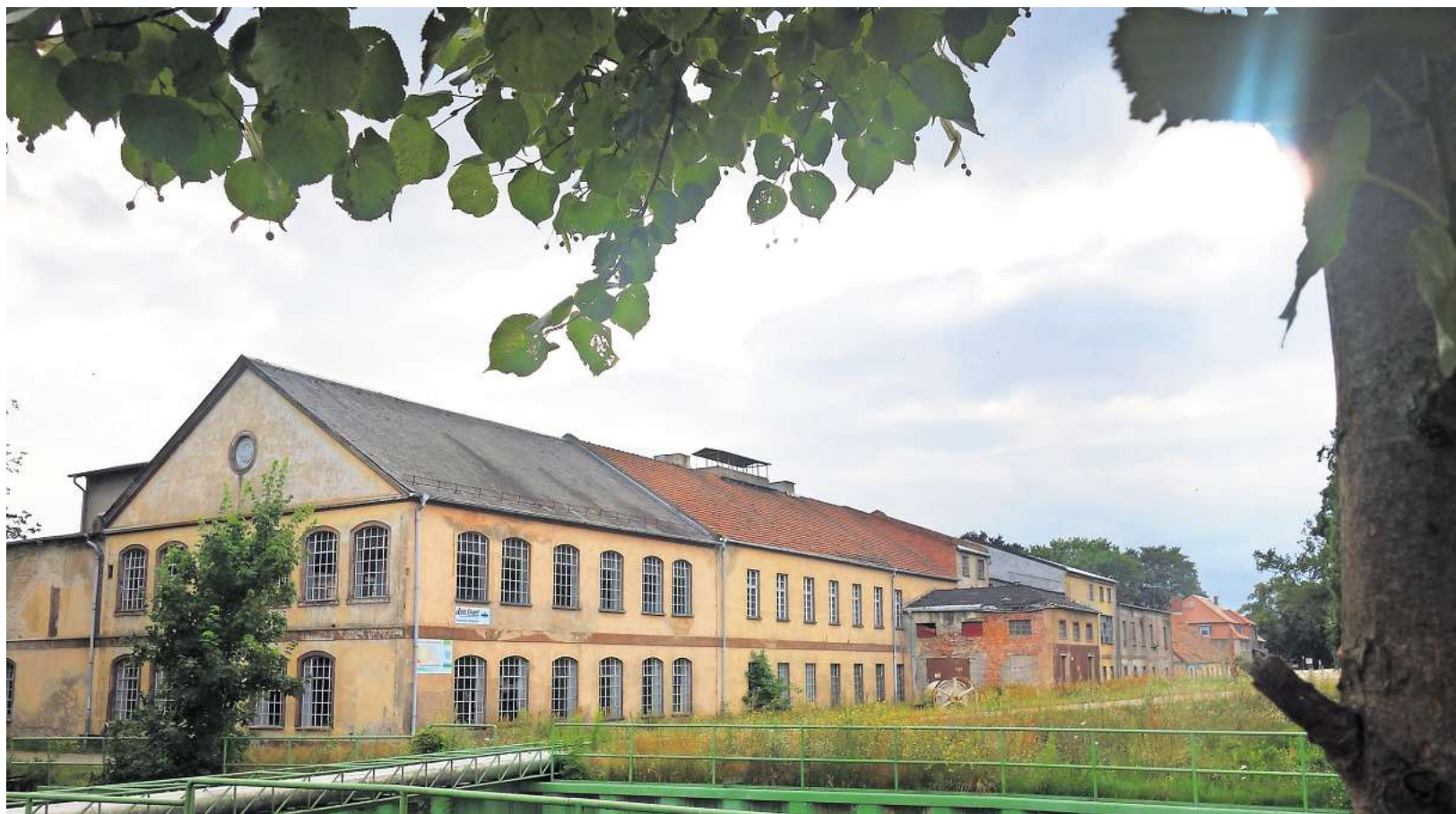
Im Mai dieses Jahres wurden erneut Teile des Daches gesichert. Mit Hilfe von Spenden soll es schon demnächst weitergehen.
