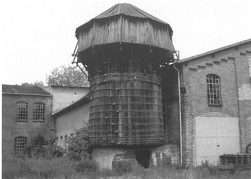
▲ Der hölzerne Klärturm.
